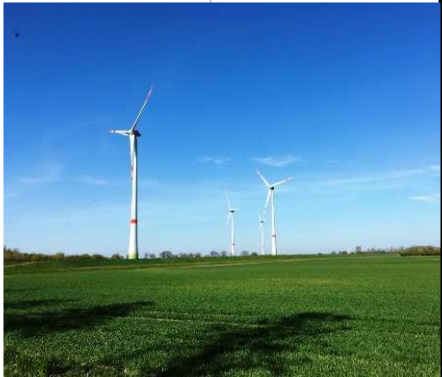
↑ Vollendet: Windpark Schlüsselburg
